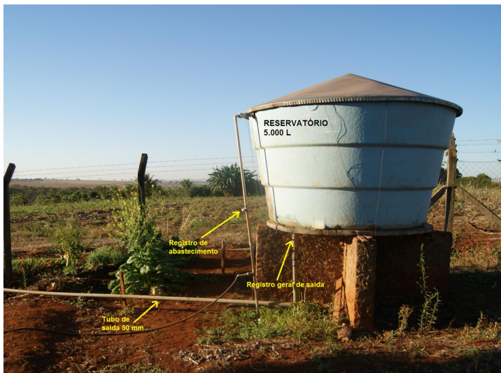
Figura 4. Reservatório da água utilizada na irrigação do experimento
